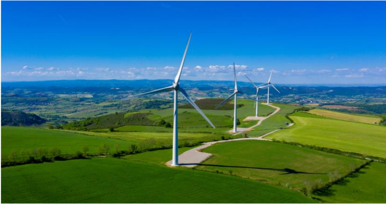
Mehrere Windenergieanlagen auf Höhenzügen
